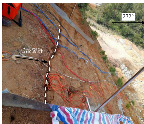
图 1 研究边坡现场图
